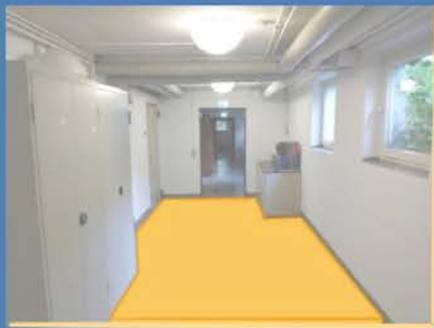
Das Gebäude ist größtenteils unterkellert, siehe Kapitel 2.5. Der untere thermische Gebäudeabschluss wird im unterkellerten Bereich vom Fußboden des Kellergeschosses und im nicht-unterkellerten Bereich vom Fußboden des Erdgeschosses gebildet. Es handelt sich um Stahlbetondecken ohne Dämmung.
