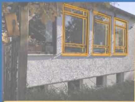
Die Fenster des Gebäudes wurden 1987 ausgetauscht. Im Kellergeschoss sind Modelle mit Kunststoffrahmen verbaut, im Erdgeschoss Modelle mit Holzrahmen, jeweils mit Zweifachverglasung. Die Fenster auf der Südost- und Südwestseite des Gebäudes sind im Erdgeschoss mit Außenjalousien für den sommerlichen Wärmeschutz ausgerüstet.
