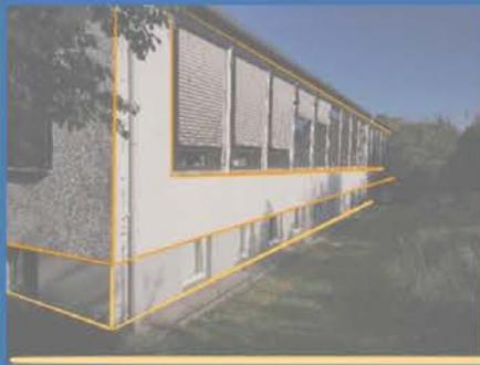
Die Außenwände sind gemauert, in einer Stärke von 30cm. Eine Dämmung wurde bisher nicht vorgenommen.
